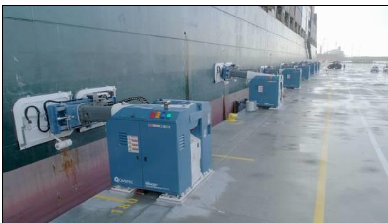
Slika 10: Automatski vakuumski privezni sustav MoorMaster u luci Napier, Novi Zeland
